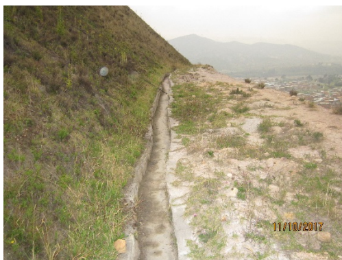
Fotografía No. 2. Sociedad Ladrillera Prisma S.A.S. Se aprecia los dos drenes instalados en la berma 2 del cierre sur y los trinchos construidos, con el fin de evitar el desprendimiento del material vegetal en el talud 1 del citado sector.
